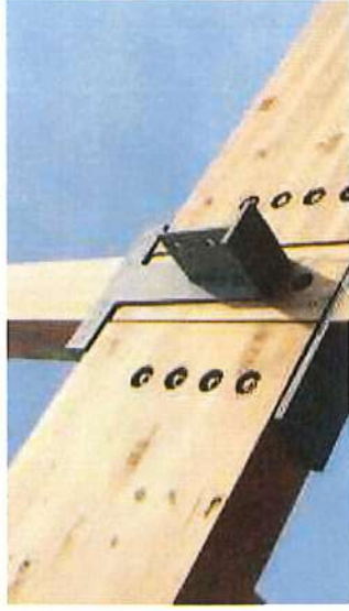
VIGAS PRINCIPAIS EM MADEIRA COM ALMA METÁLICA IMPLUVIUM ATRIO DOMUS
